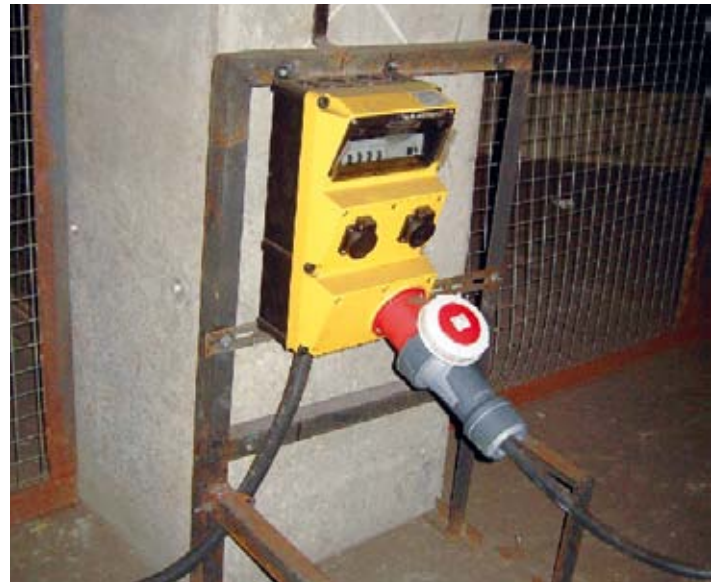
Казанский метрополитен, перегонный тоннель / Россия
